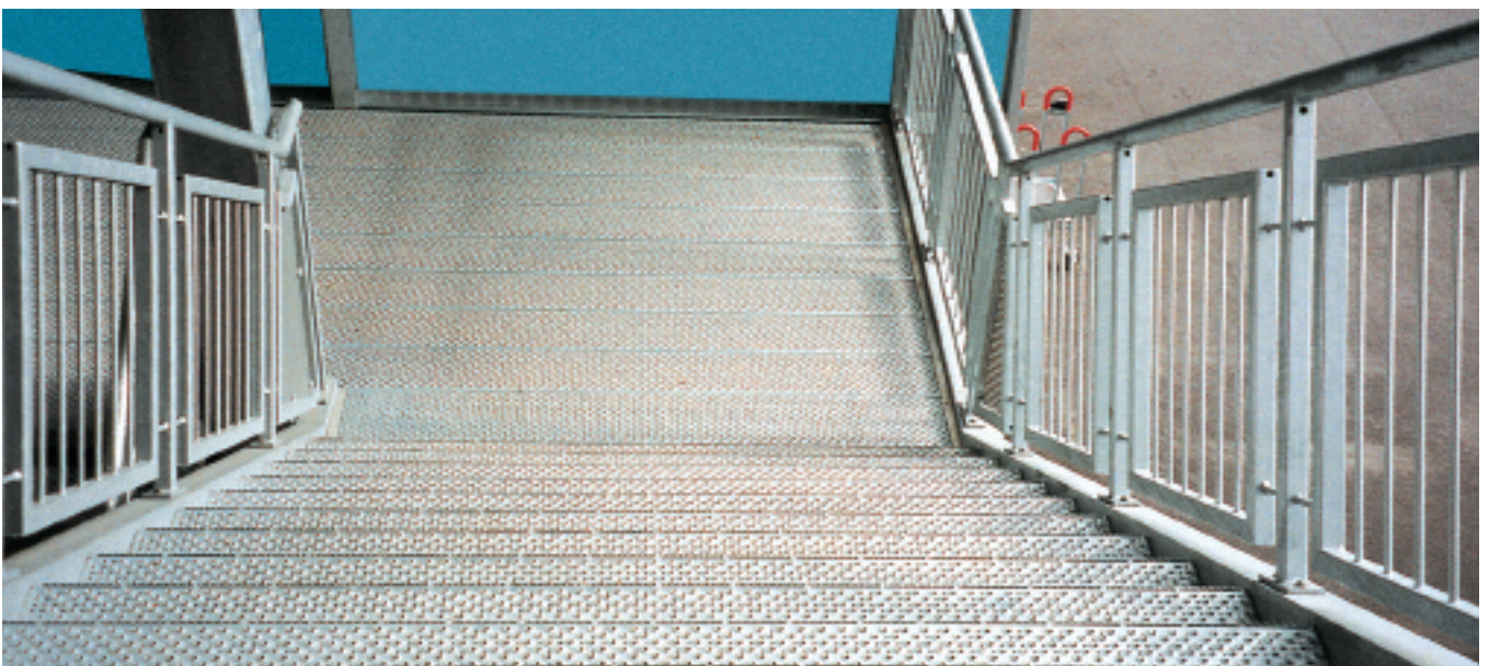
Treppenanlage mit Zwischenpodest
