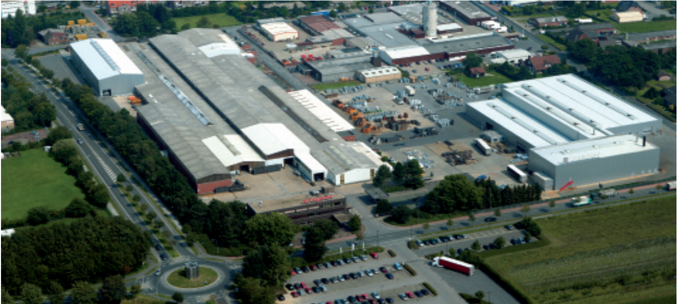
Lichtgitter - Stammwerk Stadtlohn
