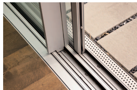
Keine Stolperfalle: Die Führungen lassen sich bodeneben integrieren.
